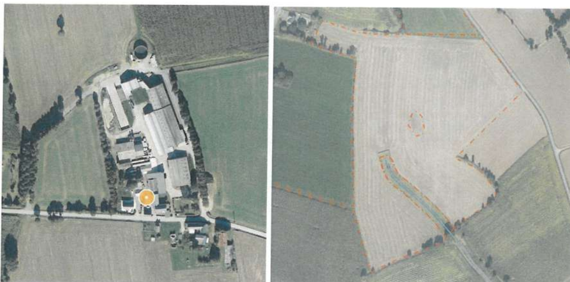
Figures 6 : Vues aériennes de l'implantation du site principal et îlot 200 en cours d'aménagement Breizh Bocage
